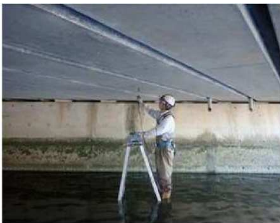
[ 脚立による定期点検状況（桜橋） ]
