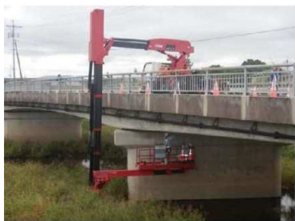
[ 橋梁点検車による定期点検状況（二口橋） ]
