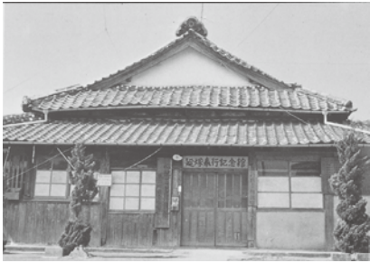
木造建築時代の延塚記念館 正面中央の大棟瓦が前回紹介した文久四年銘の三階菱瓦。
