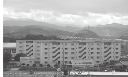
築上町役場 本庁 屋上から撮影
