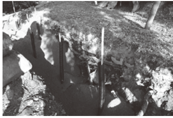
▲根周囲に良質土を漉き込み、有孔管設置
