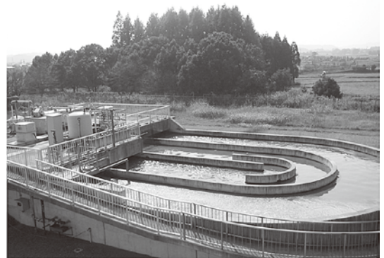
築城浄化センター
