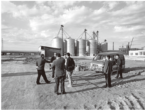
建設中の製米所
