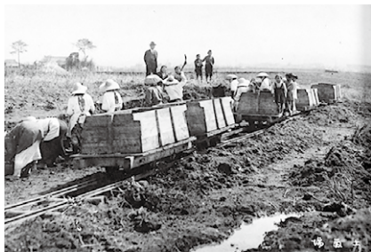
正八幡神社移転先の造成工事 左奥に移転前の神社が見える。 現在は基地内にある 「憩いの森」がかつての神社社叢。 『八田庄鎮座郷社正八幡神社移転改築記念写真帳』（昭和18年 / 金富神社所蔵）より
