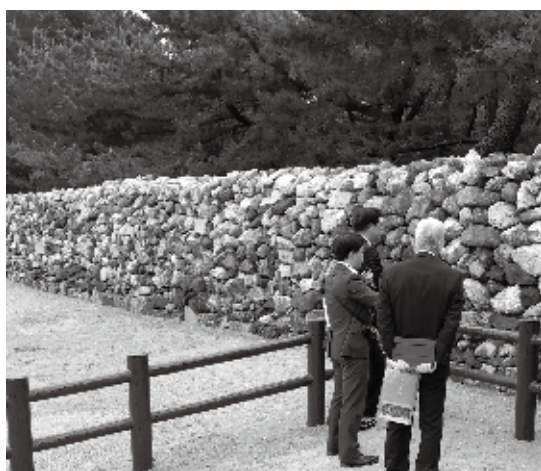
国史跡 生の松原元寇防塁 (博多湾岸に築かれた全長 20 kmの防塁の一部)
