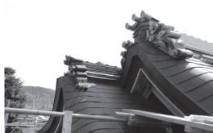
▲ 修理した旧蔵内邸の正面屋根
