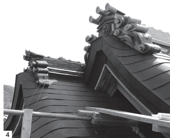
1. 檜皮葺き作業中の軒付 2. 箕甲部分の下地修理 3. 家紋が入った破風の檜皮仕上げ 4. 鬼瓦も部分補修した正面屋根
