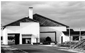
築上町有機液肥製造施設 所在地 築上町大字湊1287 敷地面積 13,504m 2 処理能力 18.7kl/日 竣工 平成6年3月
