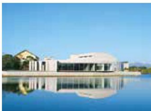
2 火葬場(H21年完成)福岡県美しいまちづくり建築賞大賞受賞
