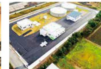
8 第2有機液肥製造施設完成
