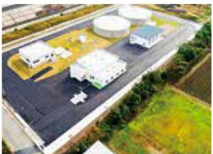
8 第2有機液肥製造施設完成
