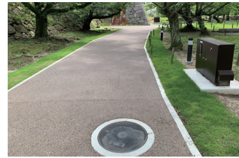
脱色アスファルト舗装（福岡城跡）
