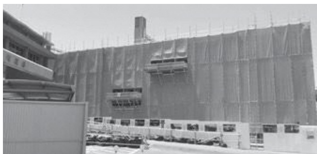
▲建設中の新庁舎
