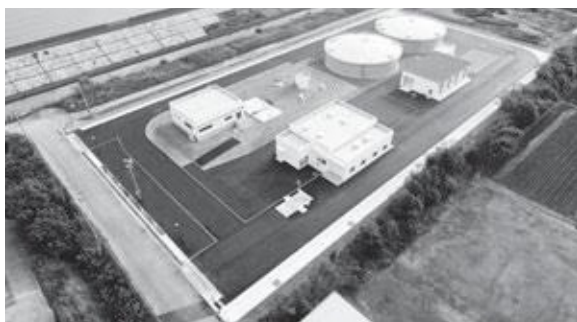
▲築上町第2有機液肥製造施設
