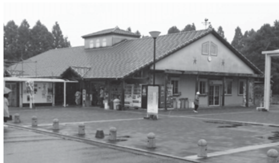
築上町物産館「メタセの杜」
