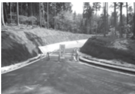
工事中の林道
