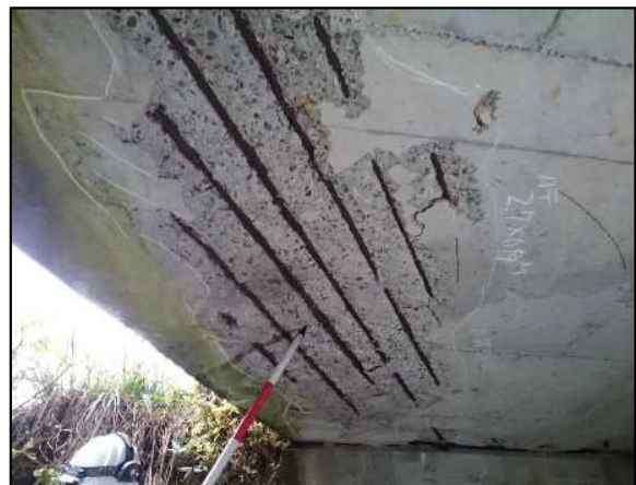
[ 船川原橋 上部構造（主桁：剥離・鉄筋露出） ]
