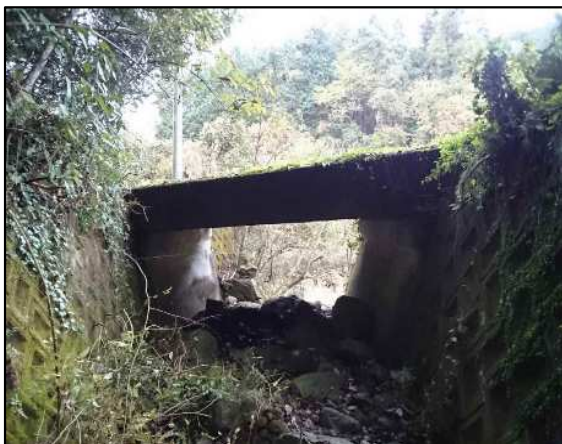
[ 船川原橋 上部構造（主桁：剥離・鉄筋露出） ]
