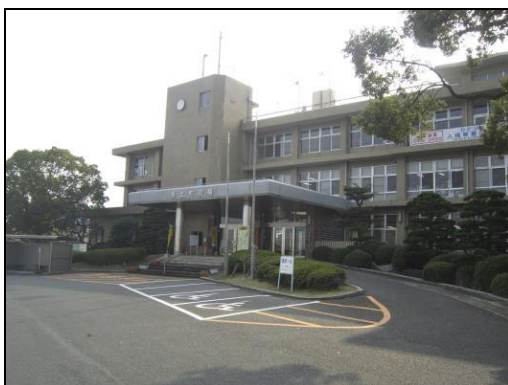
図：現在の本庁舎の外観
